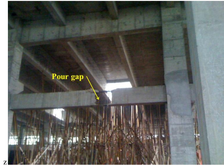
Fig. 1 A pour gap in a concrete beam
